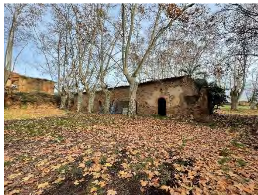
Vue générale façade Ouest
