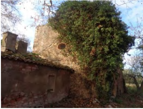
Vue générale façade Est en R+1, source : CDES 2023
