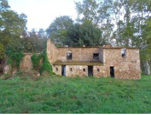
Vue générale façade Sud, CITADIA 2024
