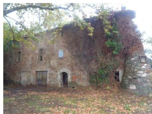
Vue générale façade Sud, CITADIA 2024
