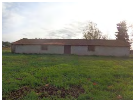
Vue générale de la façade Ouest
