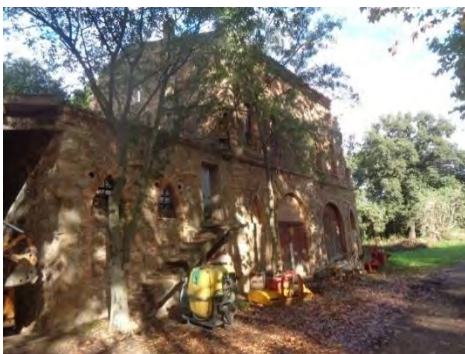
Vue générale façade Est, CDES 2023
