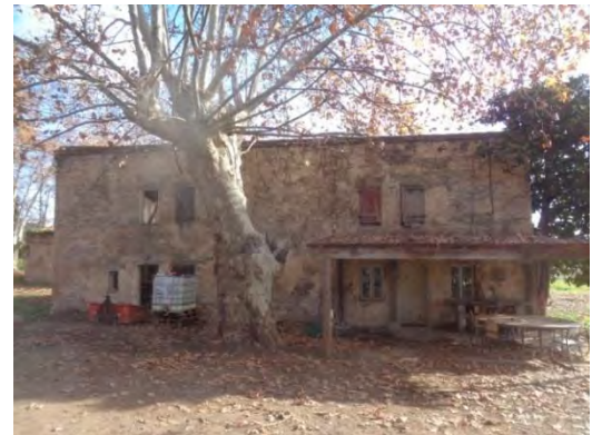
Vue générale façade Ouest, CITADIA 2024
