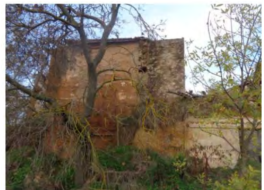
Vue générale façade Est, CDES 2023
