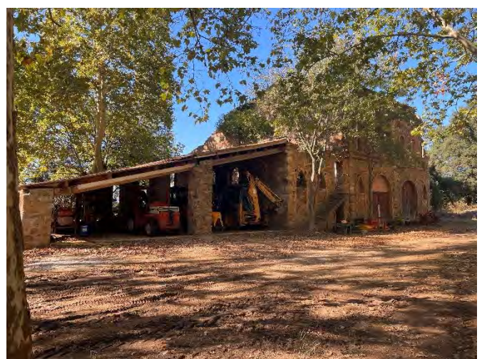
Illustration du bâti patrimonial du hameau, CITADIA 2024
