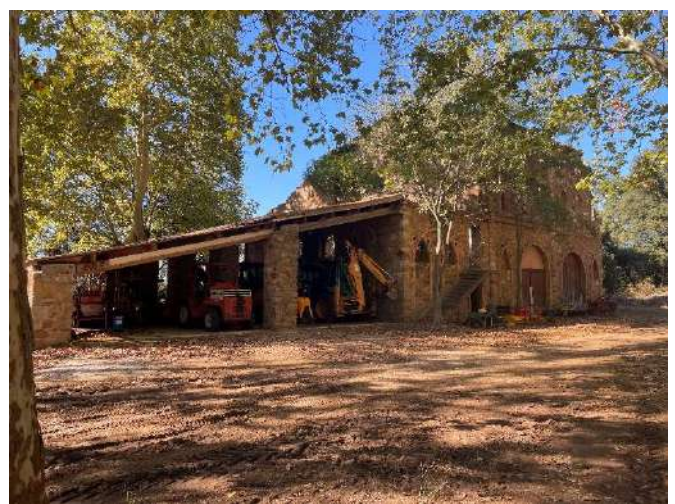
Illustration du bâti patrimonial du hameau, CITADIA 2024
