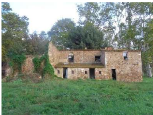
Vue générale façade Sud, CITADIA 2024
