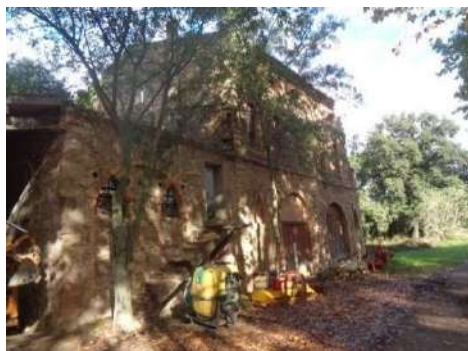
Vue générale façade Est, CDES 2023
