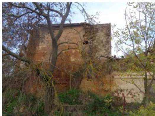
Vue générale façade Est, CDES 2023
