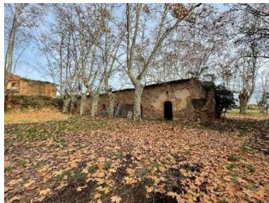
Vue générale façade Ouest
