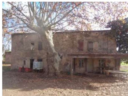
Vue générale façade Ouest, CITADIA 2024
