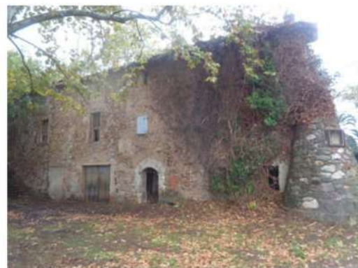
Vue générale façade Sud, CITADIA 2024
