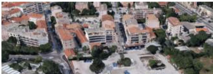
Vue de l'environnement immédiat
