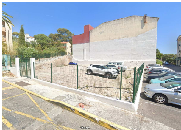
Après démolition (source : google maps)
