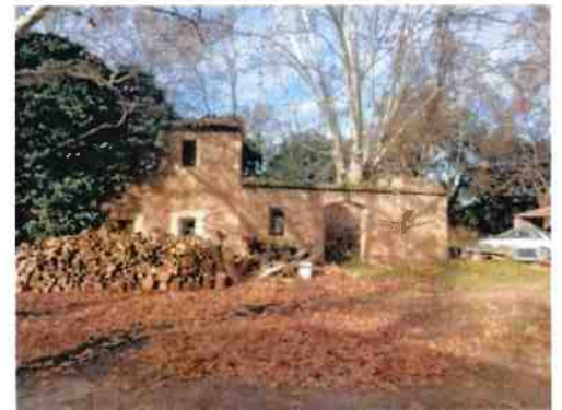
Vue générale façade Est, CITADIA 2024
