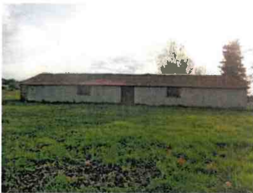
Vue générale de la façade Ouest
