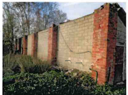
Vue générale de la façade Est
