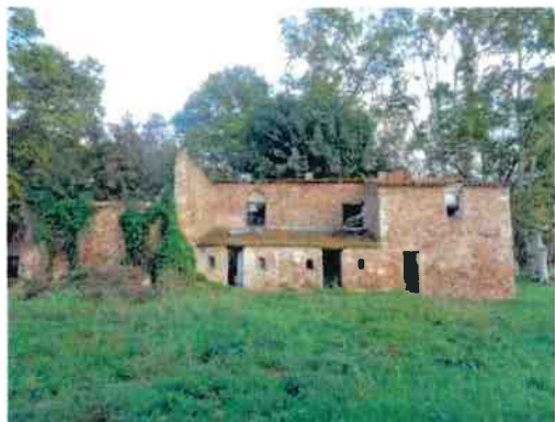
Vue générale façade Sud, CITADIA 2024
