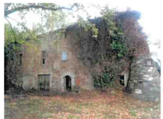
Vue générale façade Sud, CITADIA 2024
