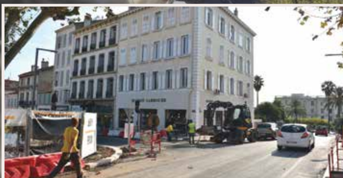
Le pavage de la voie dans le secteur ouest de la place (rue Roux Seignoret et avenue Alphonse Denis) sera prochainement terminé, permettant un rétablissement de la circulation automobile à partir du 10 décembre.
