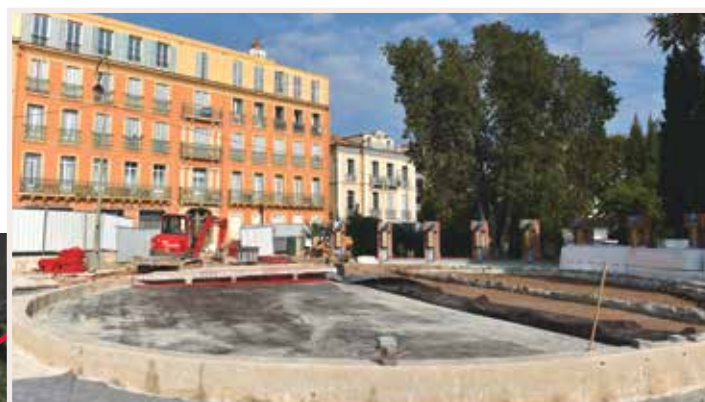
À l'emplacement de l'ancien podium est construite une fontaine sèche (sans bassin, ni eau stagnante) avec des jets d'eau escamotables.
