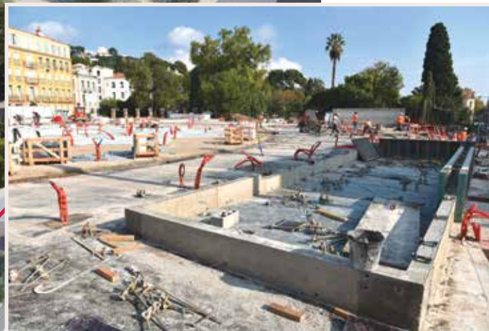
Les quatre locaux destinés à accueillir l'Office du Commerce et de l'Artisanat et des activités de restauration légère, ainsi que les ombrières sont actuellement en cours de réalisation.
