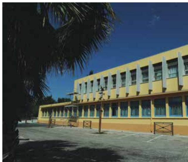
Ravalement général des bâtiments de l'école Excelsior
