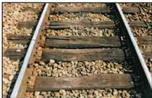
Rails courts sur traverses bois
