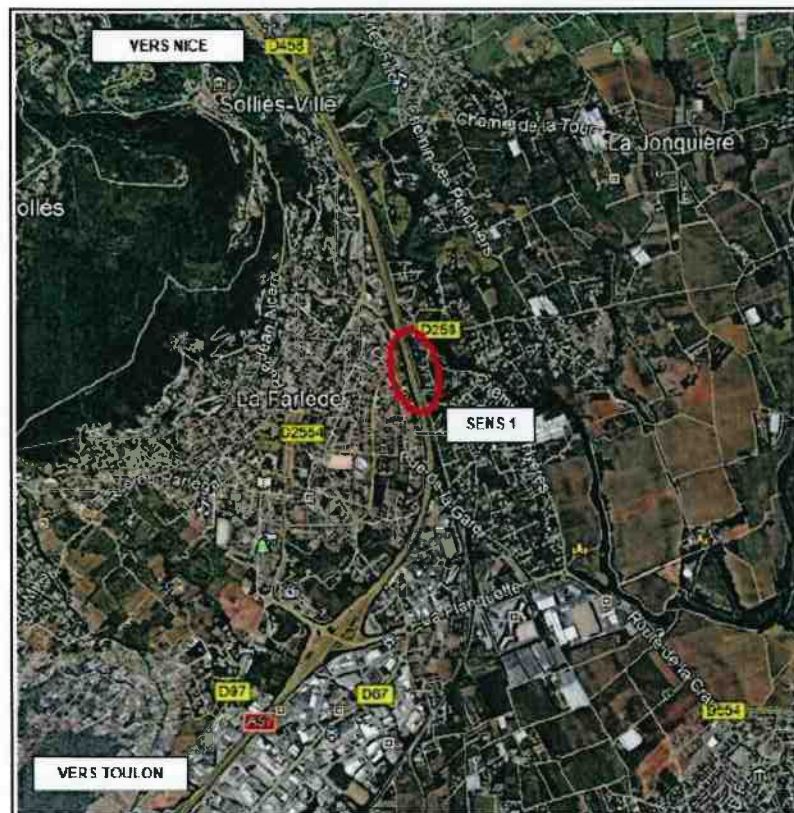
Localisation de l'écran prévu sur la commune de La Farlède (autoroute A57)
