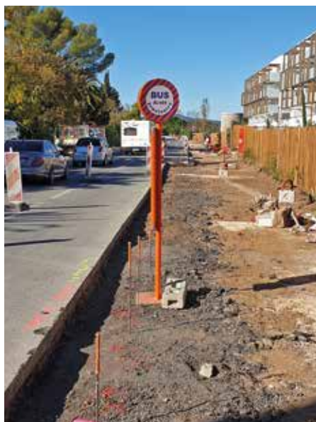
Travaux en cours sur le boulevard du Front de mer
