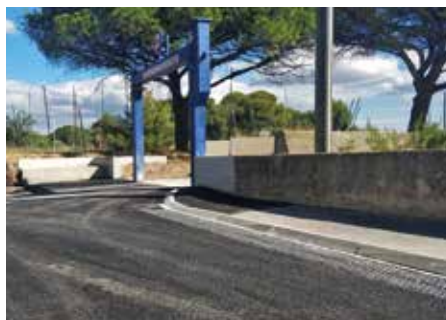
Création d'un caniveau pluvial
