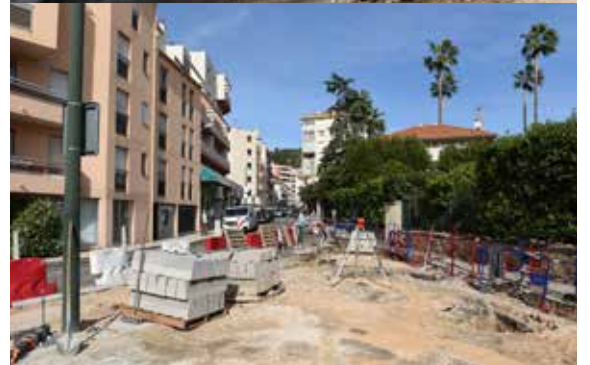
Travaux en cours autour de la place Lefebvre
