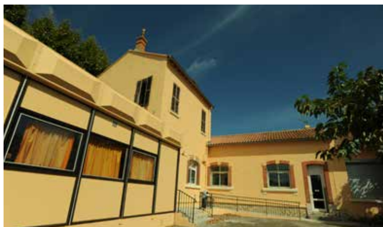
Ravalement de façade de l'école Paule Humbert à la Bayorze
