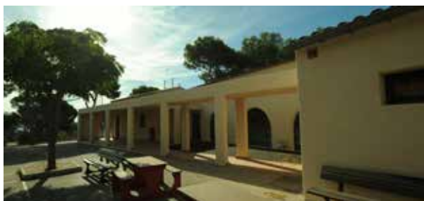
Ravalement de façade de l'école Saint-John Perse à Giens
