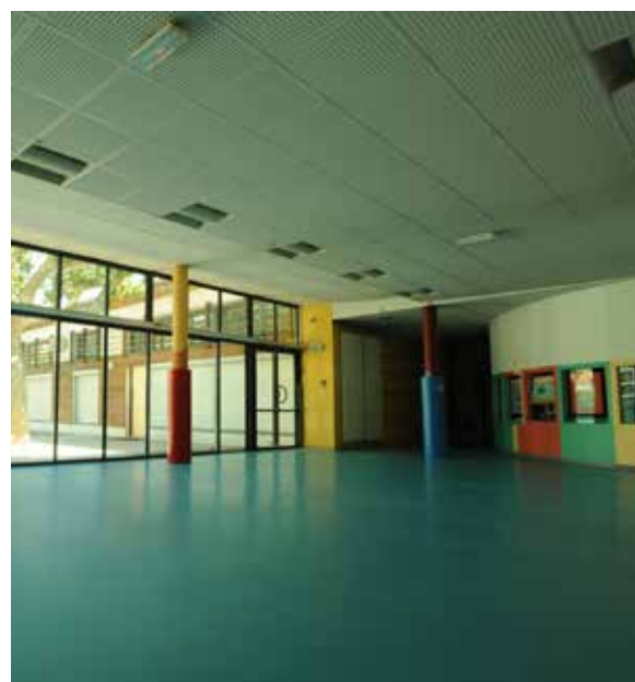
Remplacement des revêtements de sol dans plusieurs salles de l'école Françoise Dolto, avenue Gambetta
