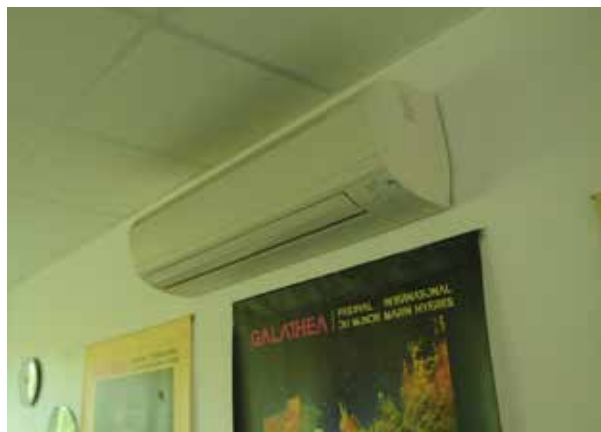
Mise en place de climatiseurs dans chaque école de la commune
