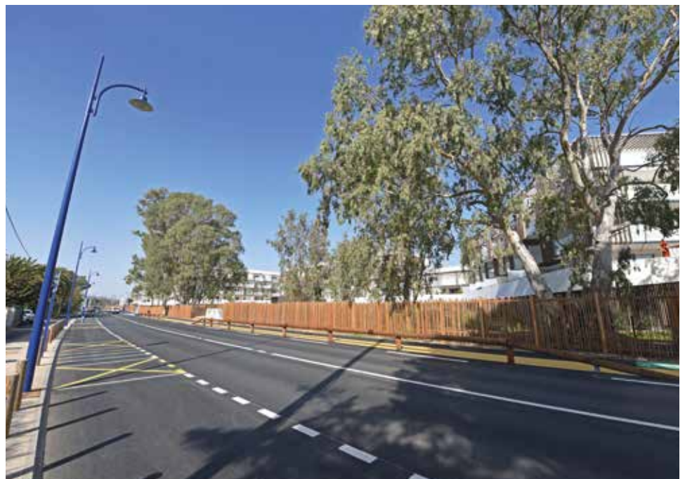
Réfection de la chaussée à l'entrée des Salins
