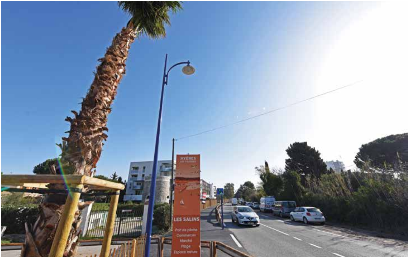
Création d'une voie verte à l'entrée des Salins
