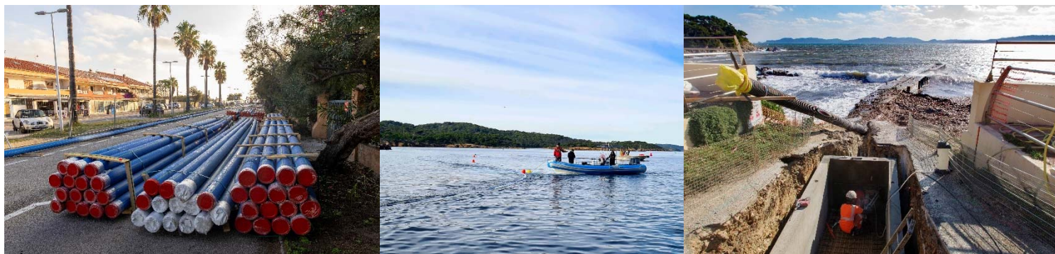
Photo 1 - Base de chantier à la Bergerie : assemblage des tuyaux de la canalisation / Photo 2 - Remorquage de la canalisation en mer / Photo 3 - Zone de travaux terrestres à la Tour Fondue
