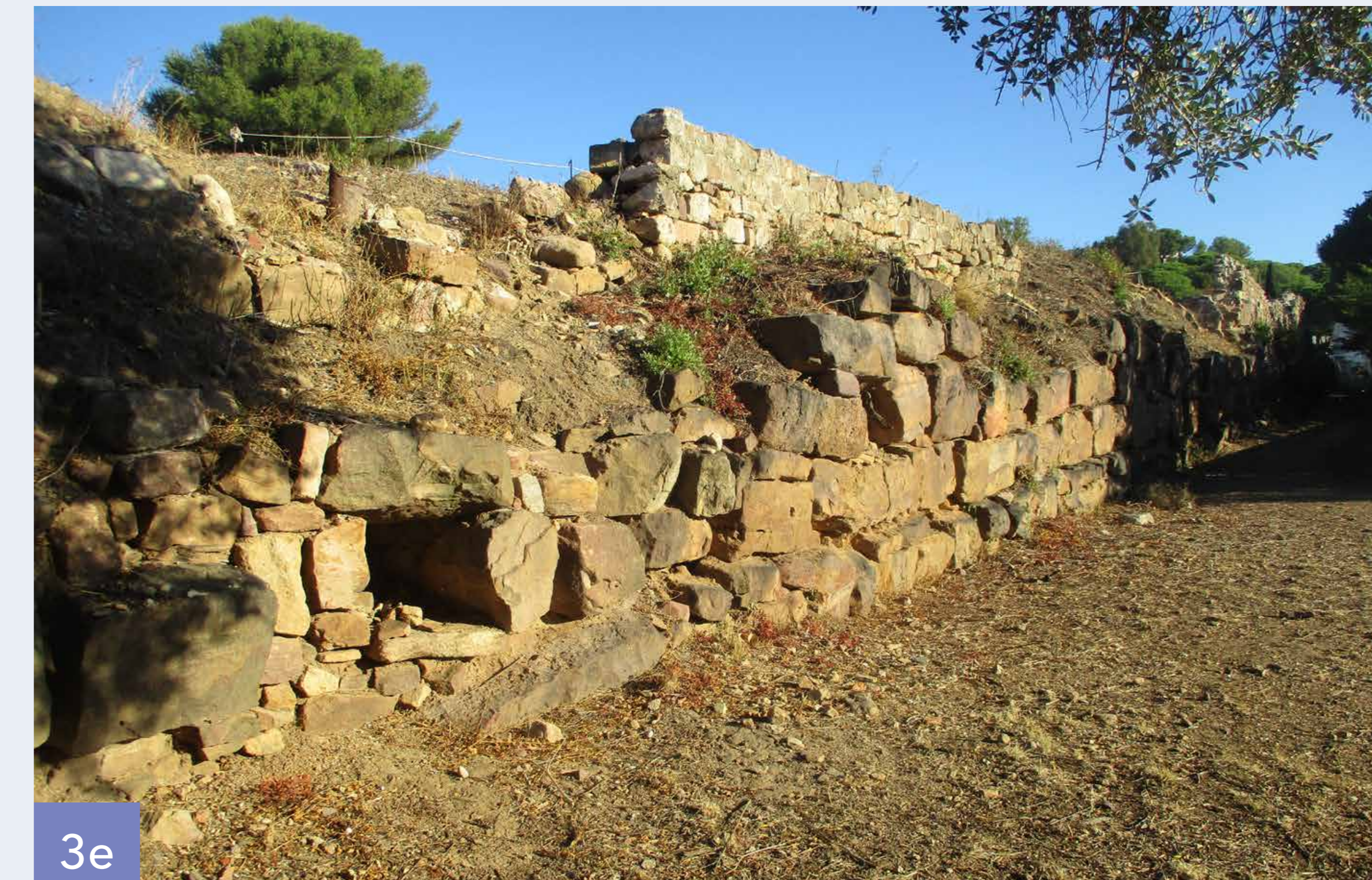
2015 / 2020 - Cette partie du mur a été entièrement remontée par l'entreprise Axes et Sites qui s'est appuyée sur les photos d'archives pour remettre les blocs à leur place.
