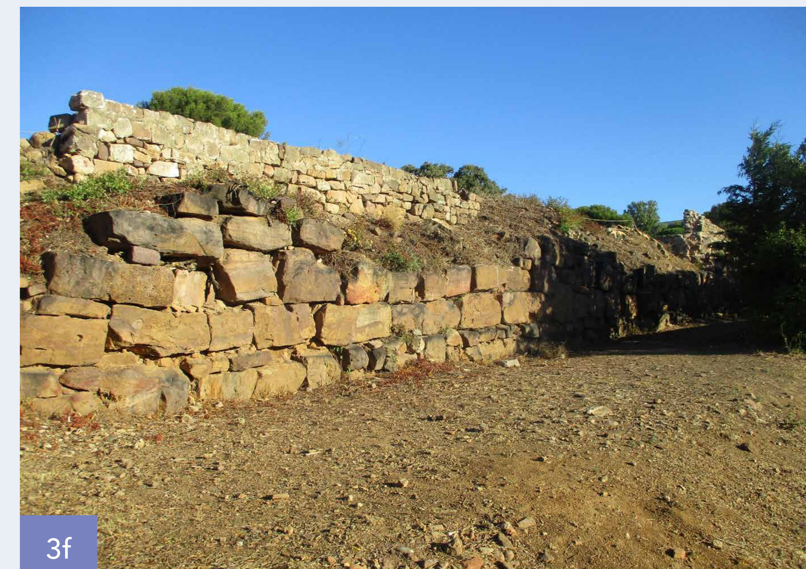
2020 - L'enlèvement des arbres qui surplombaient le mur a été nécessaire pour protéger le rempart.
