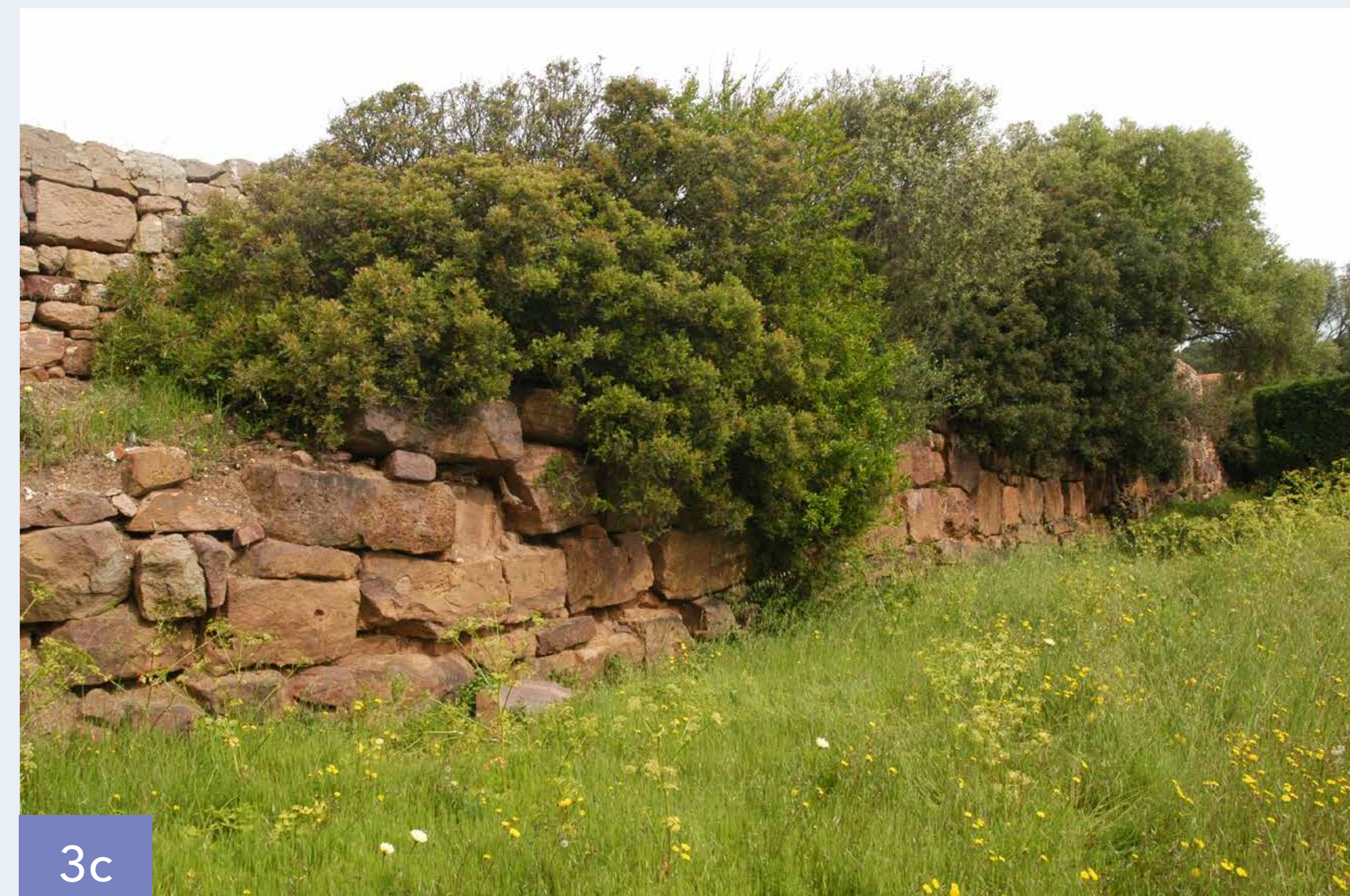
3c : 2008 - Les racines des arbres et arbustes se sont développées entre les pierres - © M.Bats 3d : 2014 - Une partie du mur s'est effondrée à la suite de violentes pluies.
