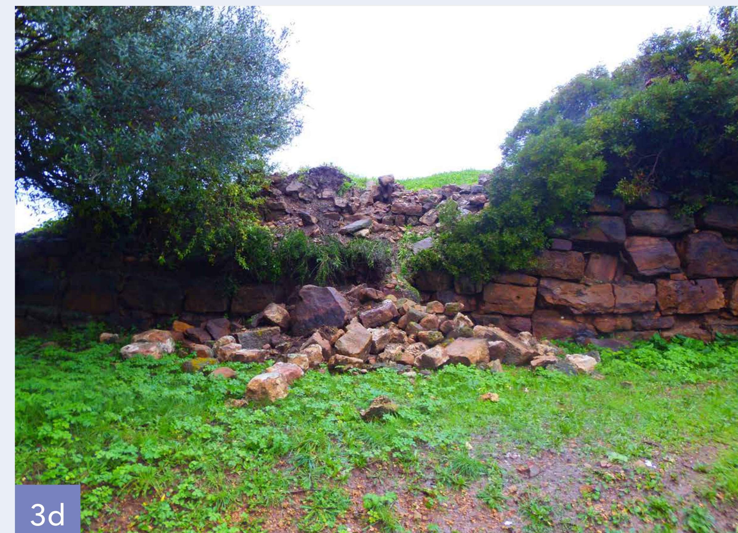
3c : 2008 - Les racines des arbres et arbustes se sont développées entre les pierres - © M.Bats 3d : 2014 - Une partie du mur s'est effondrée à la suite de violentes pluies.
